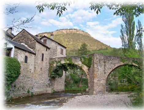
Actuellement, le pont présente une dégradation des jointures due au temps, aux infiltrations d'eau et aux racines de lierre qui s'incrument entre les pierres et qui les descellent. L'état des parapets devient aussi inquiétant suite à la dégradation de la chaux.
